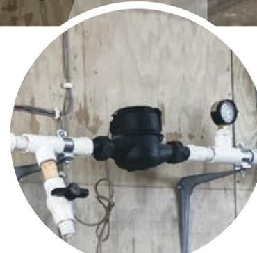
Medidor de agua de 25 mm (1")
